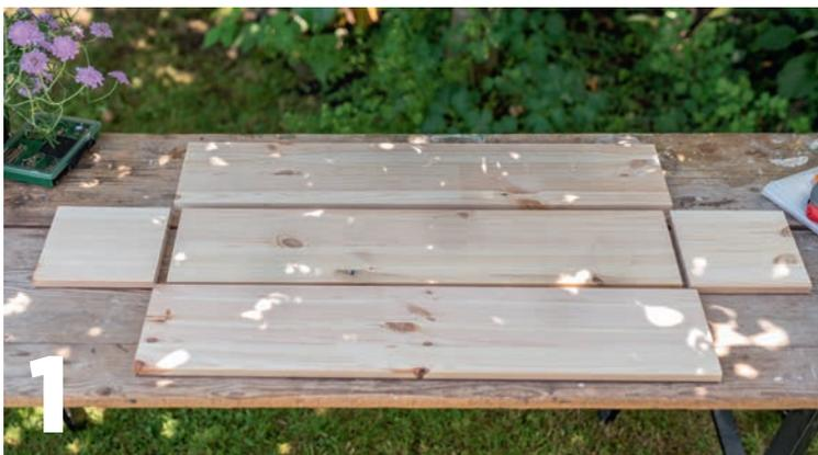
Sur les planches, qui seront ensuite vissées ensemble, marquez les trous de perçage à une distance d'environ 10 cm afin que le bois ne se fissure pas lors du vissage.
